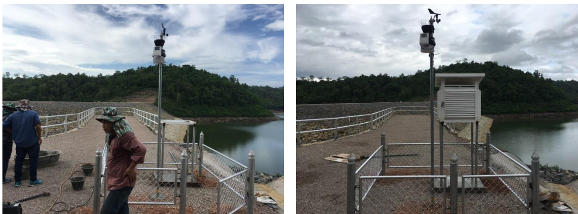
รูปที่ 5.2.1 – 2 การติดตั้งเครื่องวัดอุณหภูมิตามบริเวณห้วงงานโครงการ
